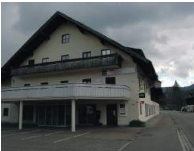
Vorgelagerter Balkon, störende Fassadenelemente und Werbeschilder
