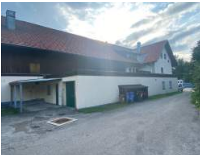
Unübersichtliche Anbauten im Norden des Gebäudes
